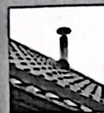
Провести осмотр головковых дымовых труб и каналов дымоходов и убедиться в отсутствии их обмерзания и закупорки.
